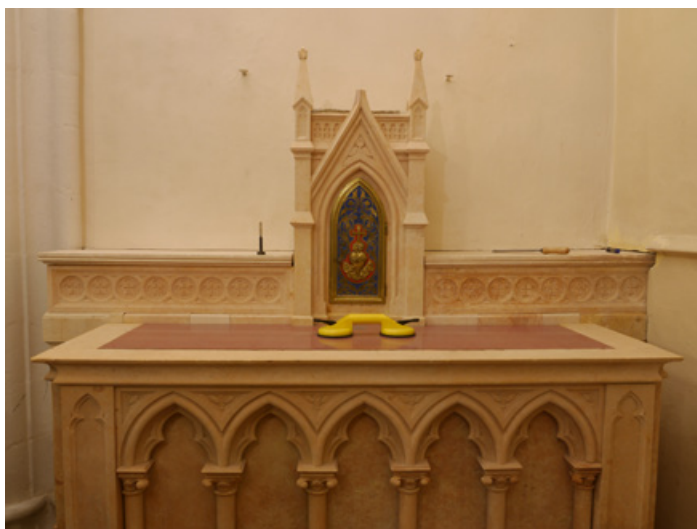
Figure 11 Autel en pierre de Cruas après nettoyage et remontage. Le fleuron sommital manque. © L. Lefèvre.
