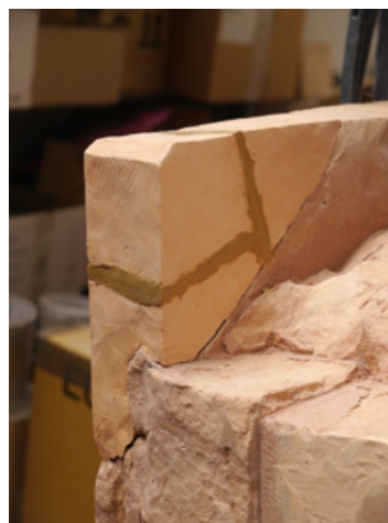
Figure 33 Entretoises en terre pour ajuster la dimension de l'angle restitué. © L. Lefèvre.
