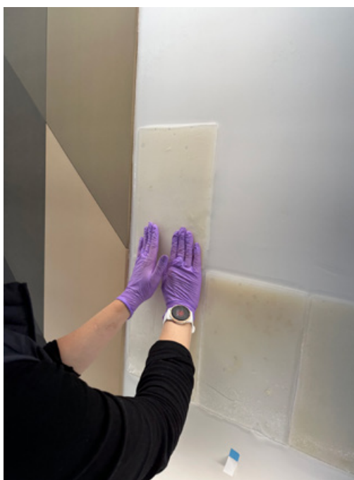
Figure 7 Plaque d'agar gel ajustée et équilibrée. © Magalie Troy, ARCOART.
