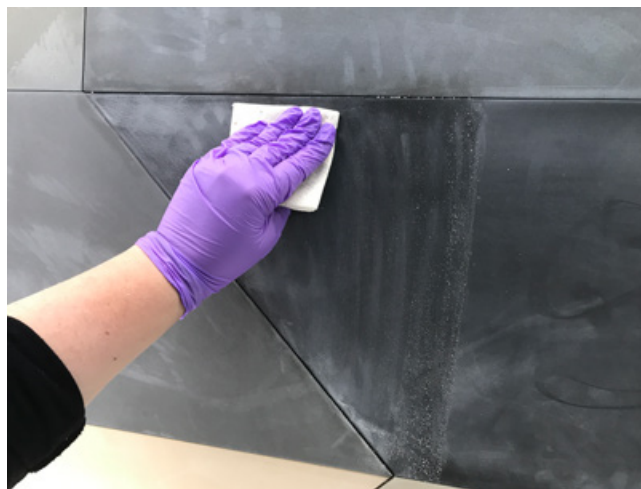
Figure 8 Gommage avec des Akatissue® et des Akapad®. © Magalie Troy, ARCOART.
