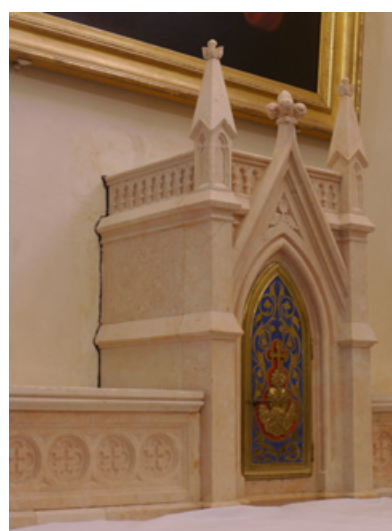
Figure 14 Après mise en place du fleuron au sommet du gâble. © L. Lefèvre.
