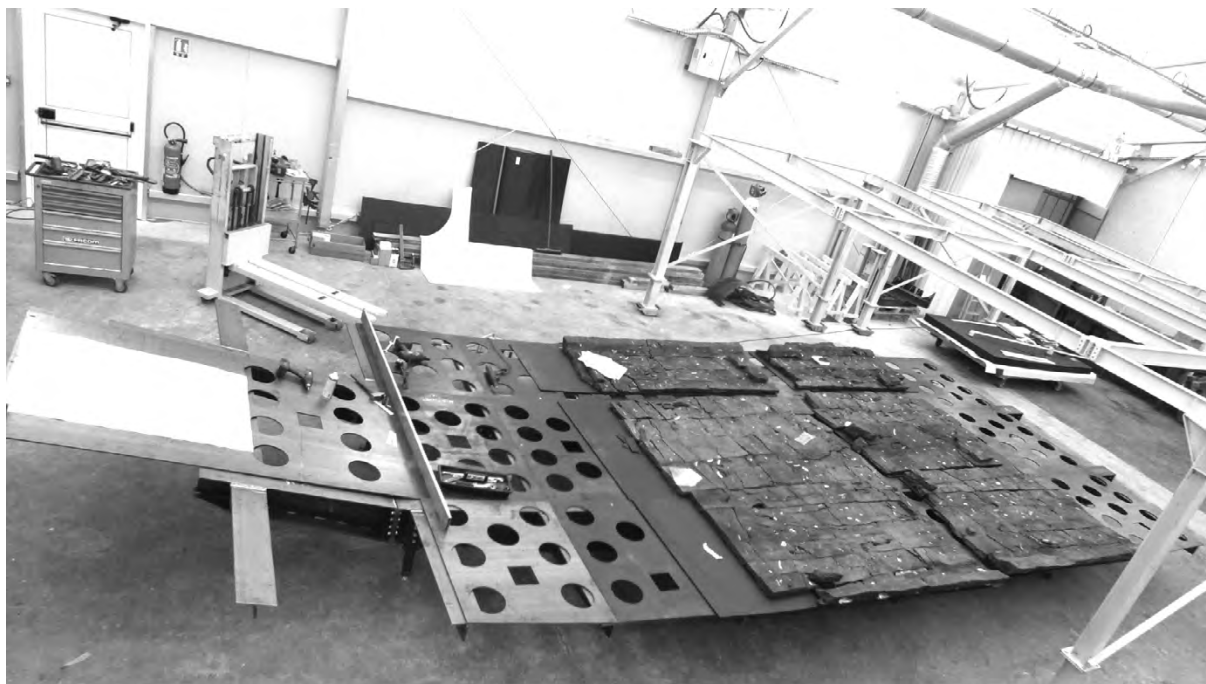
Figure 7 Montage du support de présentation du chaland. © Terpent, ARC-Nucléart.
