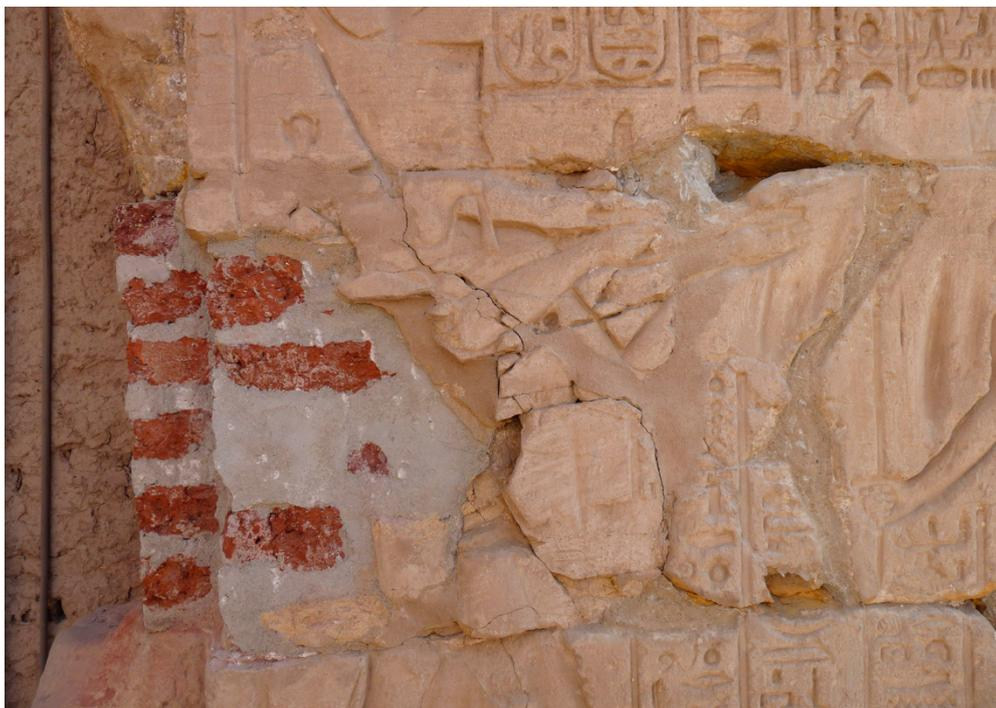
**Figure 4** Ragréage par H. Chevrier vers 1930 en brique et ciment noir.
