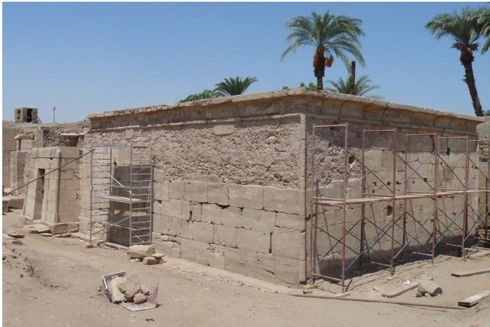
**Figure 3** Réfection des murs par G. Legrain vers 1900 en grès de remploi.
