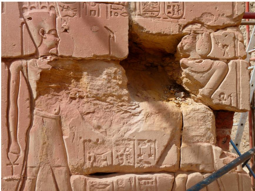
**Figure 5** Désagrégation du grès sous les ragréages au ciment. © CFEETK, L. Pieri.
