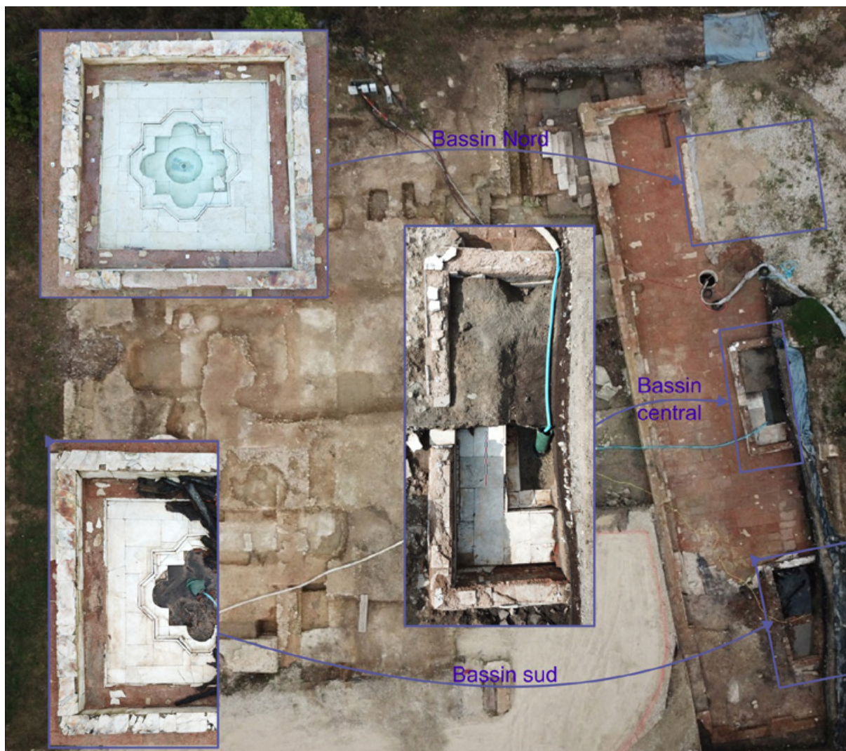
Figure 4 Vue aérienne du bâtiment et des trois bassins. © Bazin/J. Rossignol/E. Bouilly.
