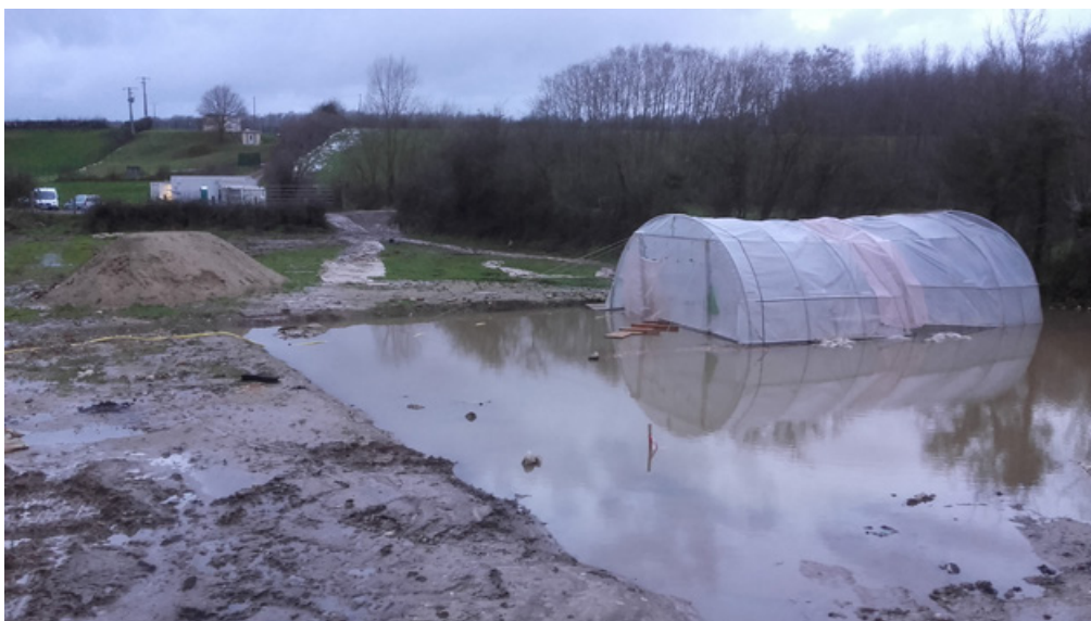
Figure 4 Serre déplacée par la tempête et crue inondant le site. © Groupement Krougly.
