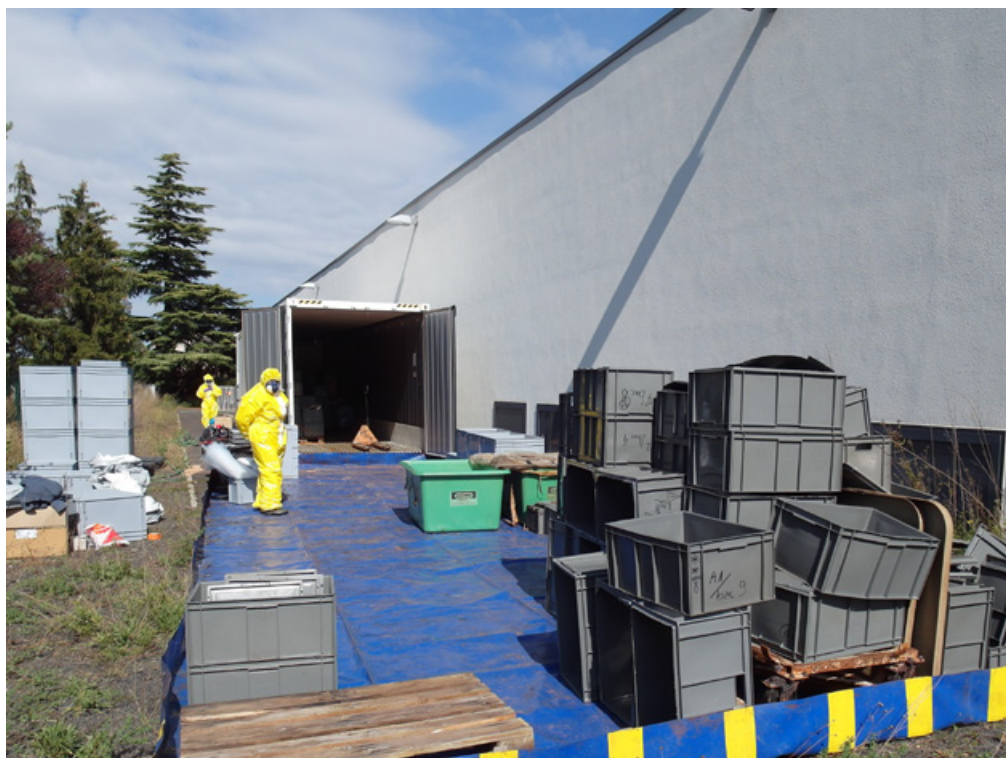
Figure 8 Un bac de rétention équipe toute la zone d'intervention. © ARC-Nucléart.
