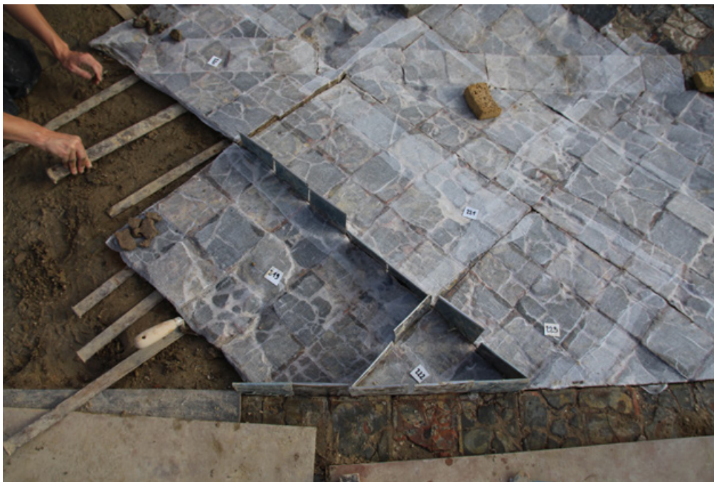
Figure 9 Dépose des plaques. © Groupement Krougly.
