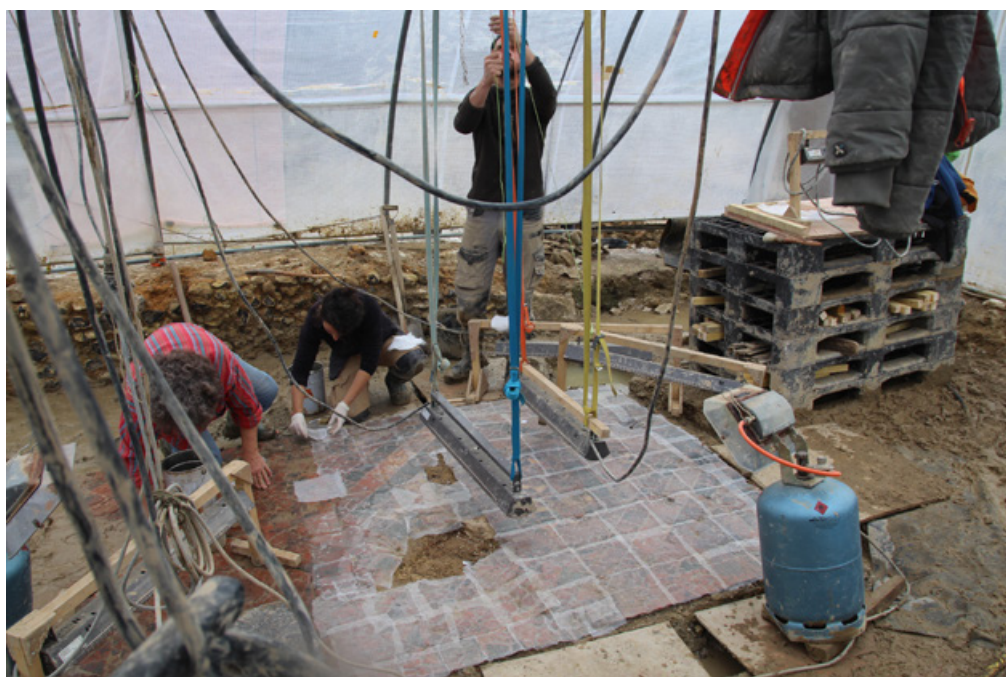
Figure 8 Second entoilage et mise en place d'un système de séchage sur mesure pour la zone à prélever. © Groupement Krougly.
