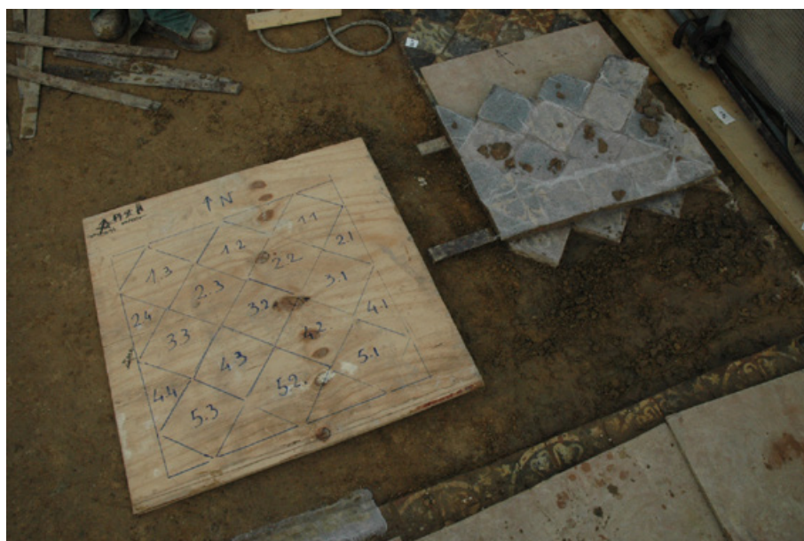
Figure 10 Création d'une « marelle » pour situer les fragments lamellaires au revers des carreaux. © Groupement Krougly.
