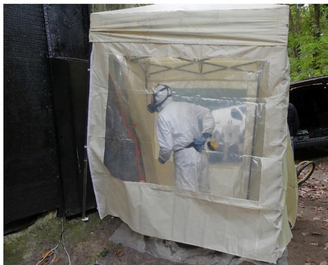
**Figure 16** *Le Cyclope*, Jean Tinguely et Niki de Saint-Phalle, Milly-la-Forêt. Confinement installé autour de la zone-test : on note également les protections revêtues par l'intervenant (combinaison en Tyvek®, masque intégral à cartouches, gants). ©A-Corros.
