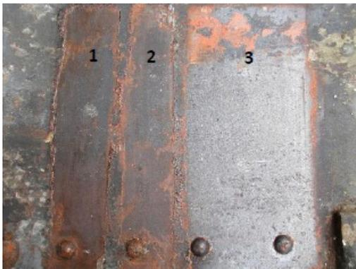
**Figure 6** Paris, gare d'Austerlitz, grande halle des voyageurs. Résultats des trois zones de décapage au gel chimique. ©A-Corros.
