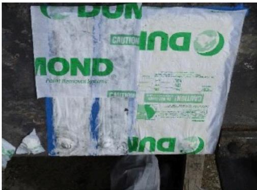
**Figure 5** Paris, gare d'Austerlitz, grande halle des voyageurs. Essais de décapage : attente confinée de 6 à 24 h. ©A-Corros.
