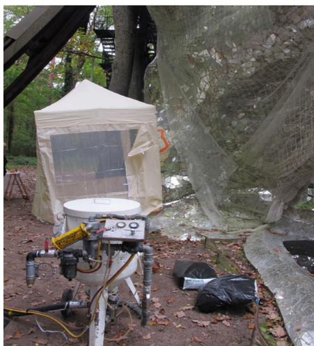
**Figure 8** *Le Cyclope*, Jean Tinguely et Niki de Saint-Phalle, Milly-la-Forêt. Procédé Sponge Jet® de décapage par projection d'éponges abrasives. ©A-Corros.
