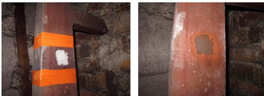
**Figure 2 (a, b)** Paris, coupole en fonte de la Bourse du Commerce. Décapage de la structure à l'aide d'un gel chimique. ©A-Corros.
