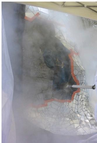
**Figure 11** *Le Cyclope*, Jean Tinguely et Niki de Saint-Phalle, Milly-la-Forêt. Mise en œuvre du procédé de cryogénie sur la sculpture. ©A-Corros.
