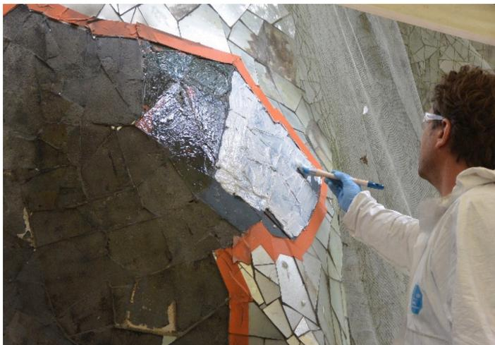
**Figure 12** *Le Cyclope*, Jean Tinguely et Niki de Saint-Phalle, Milly-la-Forêt. Application de décapant chimique sur la sculpture. ©A-Corros.
