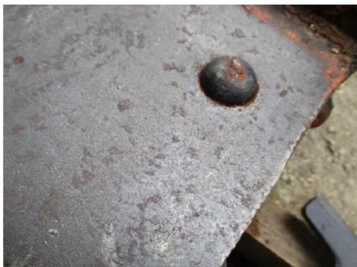
**Figure 7** Paris, gare d'Austerlitz, grande halle des voyageurs. Détail de la zone-test n°3 de décapage au gel chimique : la calamine a été « retrouvée ». ©A-Corros.
