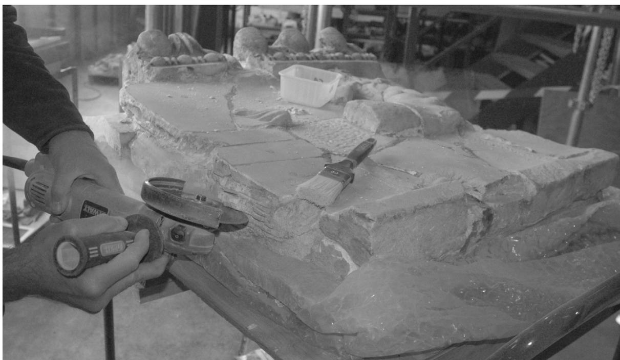
**Figure 6** Découpe du ciment à la disqueuse. © E. Desroches.
