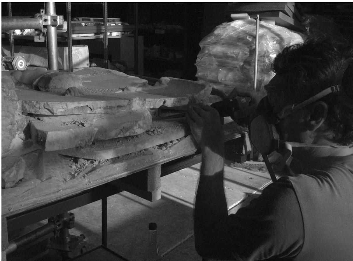
**Figure 3** Démontage du ciment liant un relief au ciseau pneumatique. En bas, la plaque de doublage, au milieu, des fragments de marbre dont certains antiques (moulurés) en remploi, en haut le relief sculpté.
