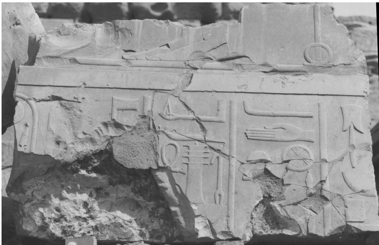
**Figure 5** Collage au ciment d'un bloc à l'époque d'Henri Chevrier, Karnak. © E. Desroches.
