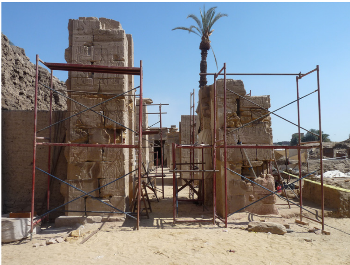
Figure 6 Porte A, élimination des anciens ragréages et ciment. © CFEETK, L. Pieri.
