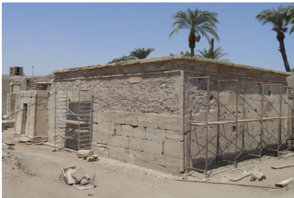
Figure 3 Réfection des murs par G. Legrain vers 1900 en grès de remploi. © CFEETK, L. Pieri.
