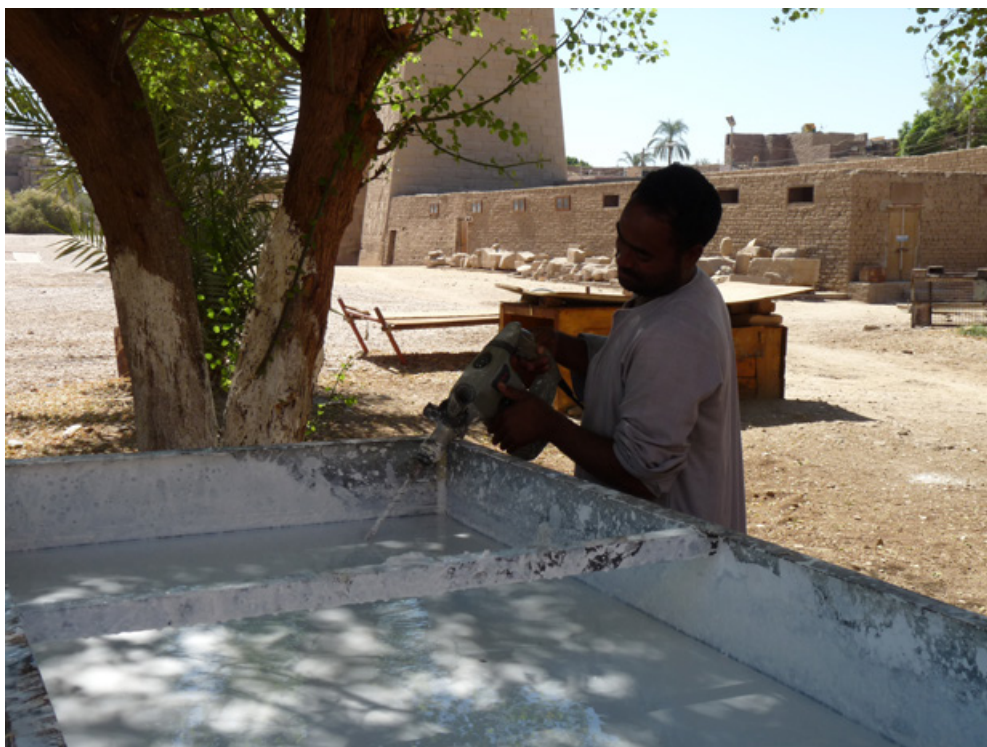
Figure 9 Fabrication de chaux en pâte sur site, malaxage. © CFEETK, L. Pieri.
