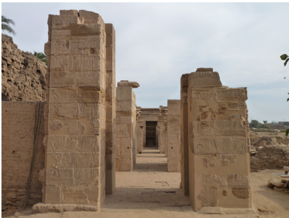
Figure 10 Porte A après réalisation des enduits de finition. © CFEETK, L. Pieri.
