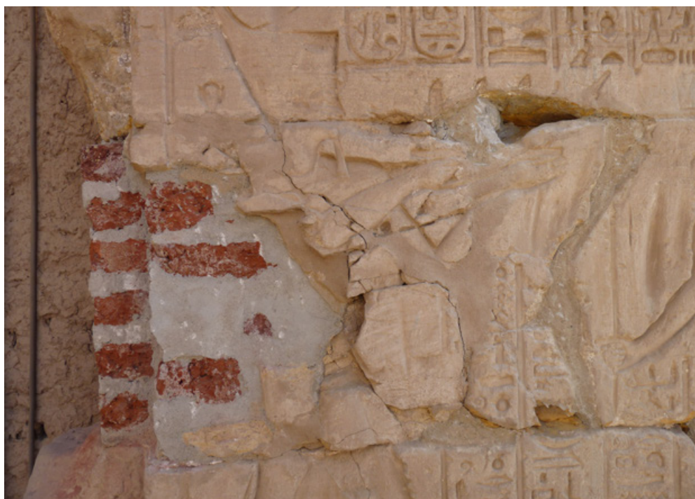
Figure 4 Ragréage par H. Chevrier vers 1930 en brique et ciment noir. © CFEETK, L. Pieri.
