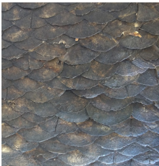
Figure 13 Restitution des écaillles en cours. © P. Polpré.
